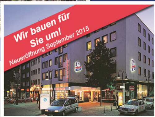
2015 Kernsanierung CityClass Hotel Residence, Köln
